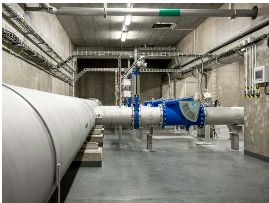
Protipovodňová opatření Karlín
